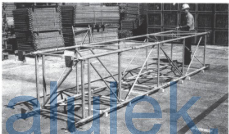
9. Вставить в концевую раму винтовые ножки и установить фиксаторы.
